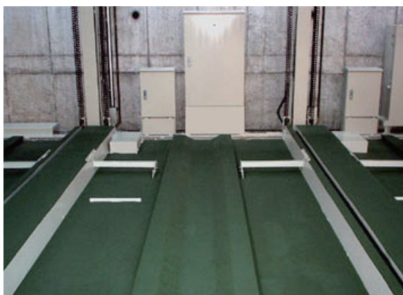
立体駐車場床面 K-888塗布
